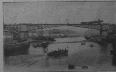
Le Pont tournant sur la Penfeld, à Brest. Au-dessous, la passerelle flottante dite Pont Gueydon. Au fond, les arènes de la marine.
